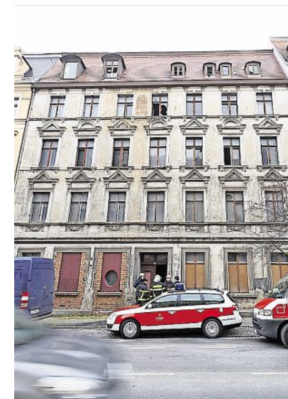
Eine Explosion im Haus Rauschwalder Straße 16 hatte vor einem Jahr tragische Folgen.
